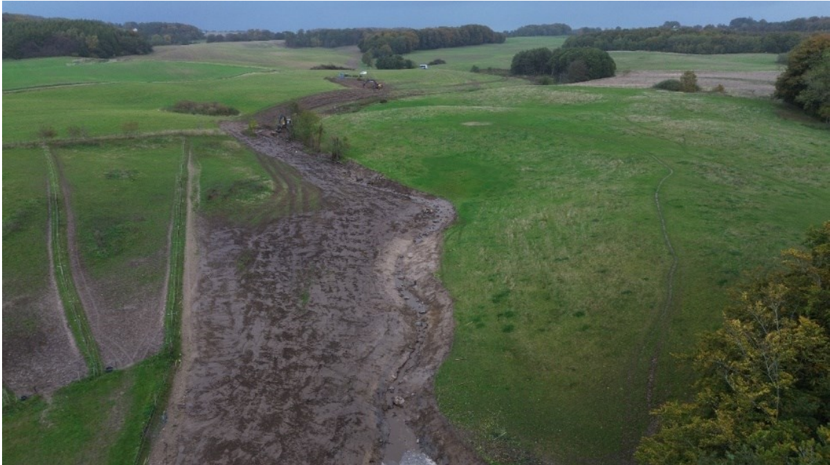
Bild 5. Bilden visar meandring och svämplan under pågående entreprenad.
