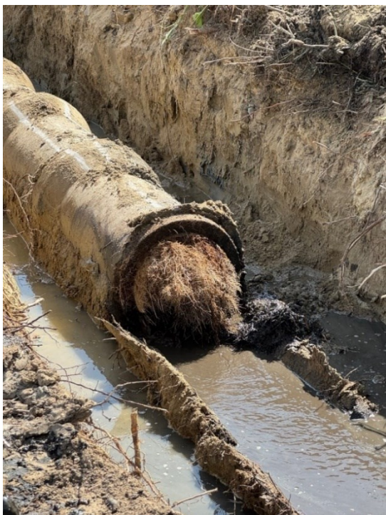
Bild 9. Bilden visar hur inloppsror i våtmark H48 i Lomma kommun såg ut innan underhållet utfördes 2025 (se bild 8).
