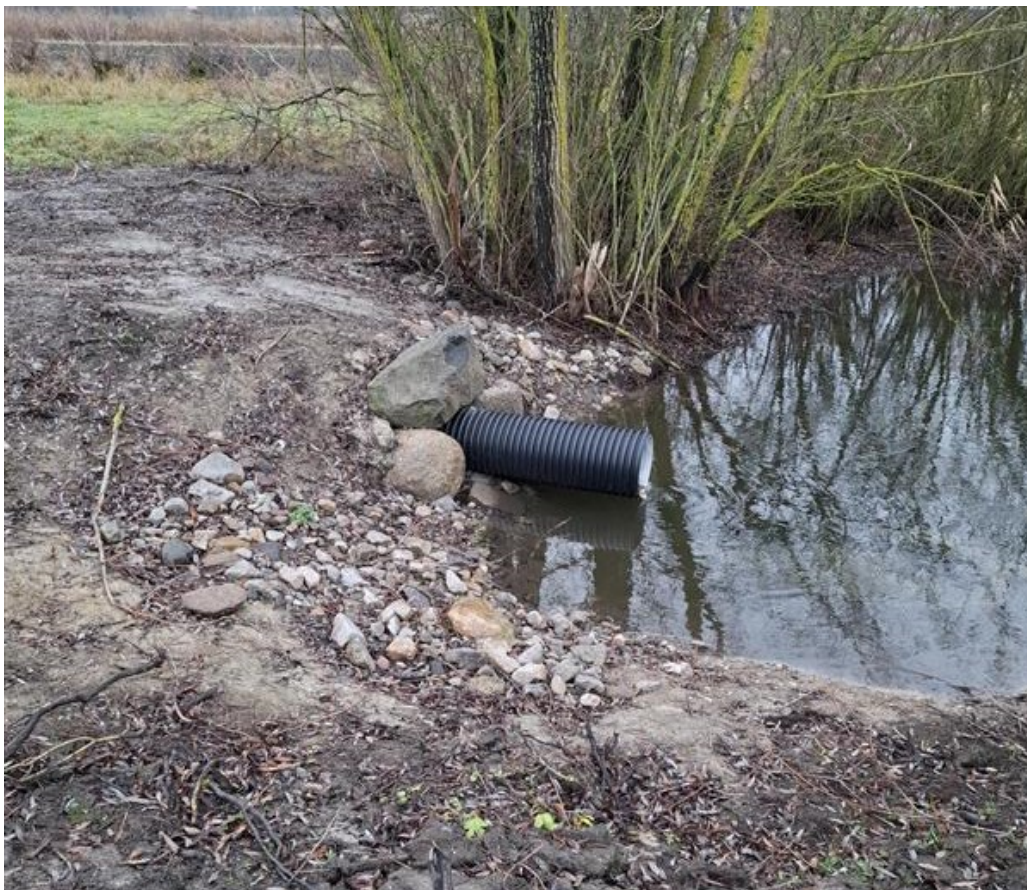
Bild 8. Bilden visar nytt inloppsror i våtmark H48 i Lomma kommun där tidigare inloppsror var igenväxt av rötter vilket minimerade intaget till våtmarken. Här har massor och sly rensats bort då våtmarken delvis växt igen.
